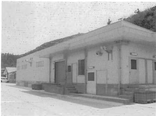
C A S凍結センターの外観 建築面積 891.67 m 2
