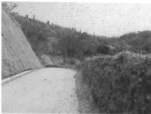
宇津屋線（御波～知々井間）整備風景
