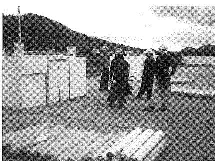
屋上には、雨漏りと暑さ対策で、断熱防水シートを使用。
